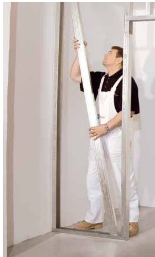
Válaszfal tartószerkezetének szerelése – függőleges CW-profilok
