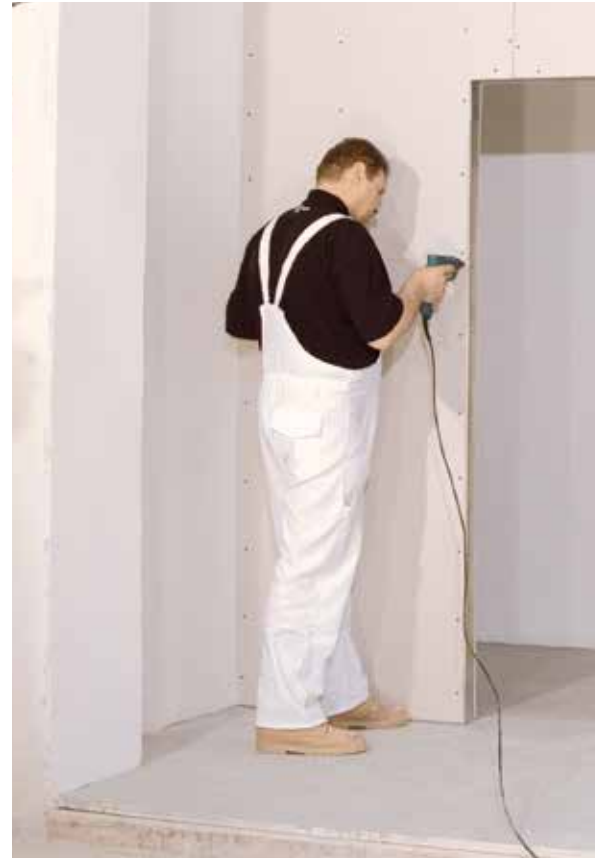
Falborítás szerelése – a válaszfal másik oldala
