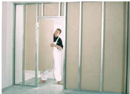
Falborítás szerelése – a válaszfal egyik oldala
