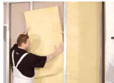
Ásványgyapot szigetelés elhelyezése a válaszfal üreges részében
